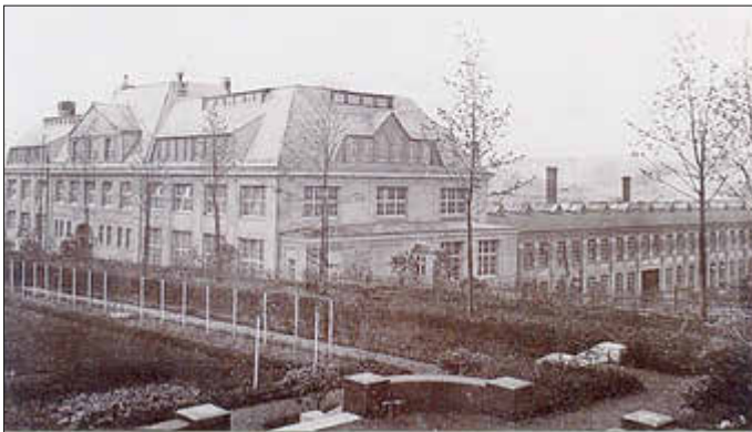
Fabrikansicht mit dem 1913 fertiggestellten Verwaltungsgebäude und dem 1904 erbauten Westflügel.
