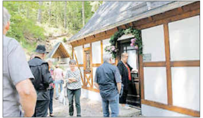
Das neue Bergmannshaus wurde in traditioneller Holzbauweise errichtet.
