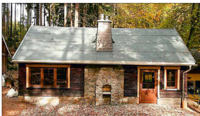
Die fertiggestellte Bergschmiede.
