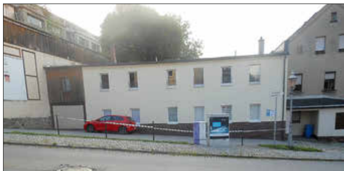
Der Anbau an das Wohnhaus (Foto Juli 1926).
