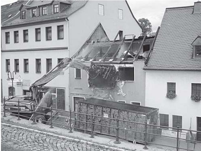
Der Abrissbagger schafft Platz für das neue Wohn- und Geschäftshaus an der Auer Straße.
