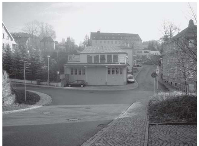
Die Bau & Möbeltischlerei Thomas Ruttloff im Jahr 2010.
