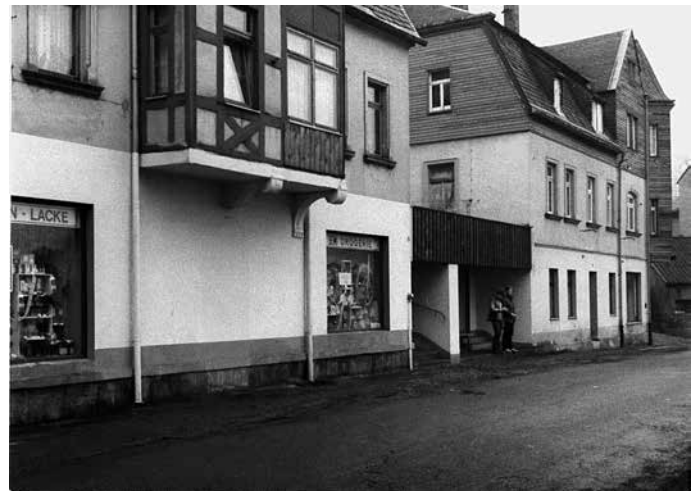
Wartehalle Bernsbacher Straße 1985 erbaut.
