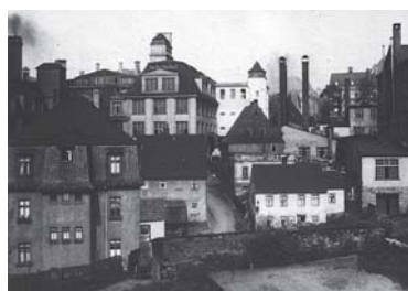
Blick vom Stiehlerweg aus auf einen Teil der unteren 7. Hufe mit der Fabrik-gasse (Fröhlichgasse) und dem Betrieb der Fa. Hermann Nier nach 1919.
