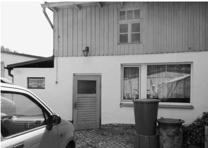
Das Nebengebäude heute, damals befanden sich dort der Abfüllraum, die Kühlanlage und der Bierkeller.
