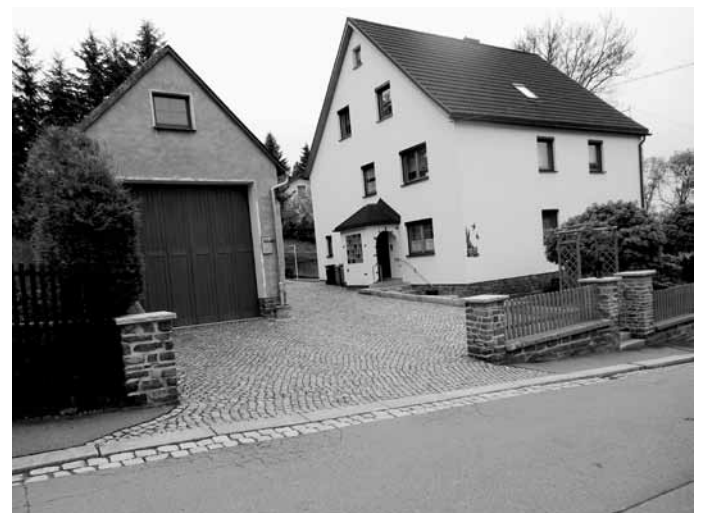
Das Wohnhaus am Bauernweg 8 im Jahr 2013.
