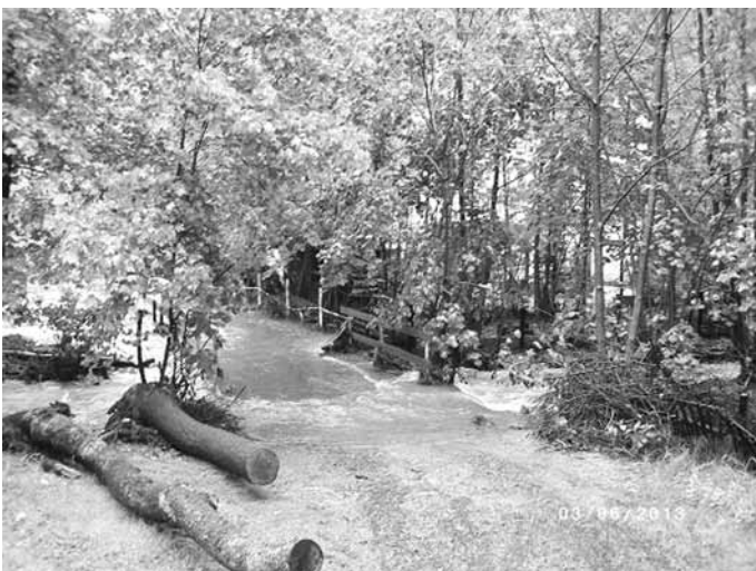
Brücke Oswaldbach, ehem. Firma FKT.
