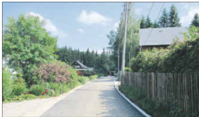
Grundhafter Ausbau Mühlberg (2).
