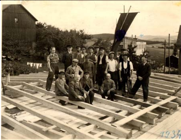
Bauheben im Jahr 1934 während des Baues des Schlossereigebäudes
