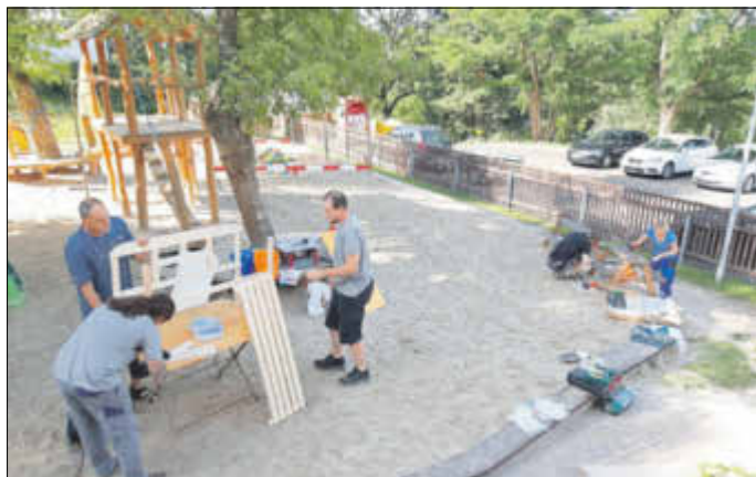
Aus Holz fertigten die Vatis die Sitzgelegenheiten und die Wasserbehälter.
