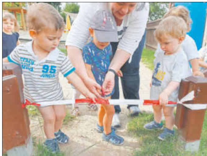
Bei der Baustelle wurde an alles gedacht. Das symbolische Banddurchschneiden wollte keiner der Jüngsten verpassen.
