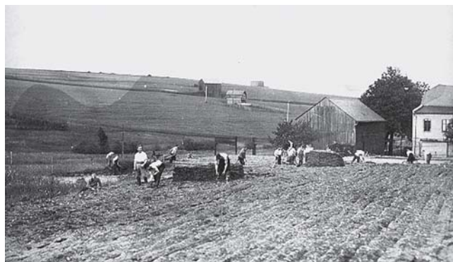
Auf diesem Feld entstand ein neuer Turnplatz.
