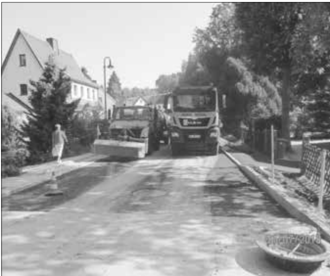
Mit dem Straßenbau wurden die Tiefbauarbeiten abgeschlossen.
