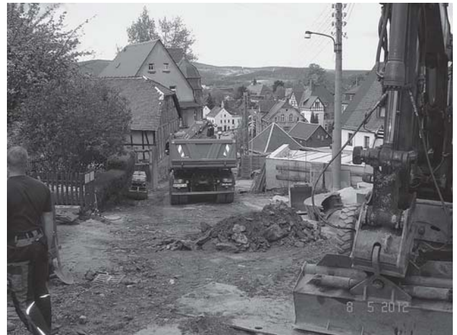
Schweres Baugerät prägt gegenwärtig das Straßenbild der „Oberen Viehtrift“.
