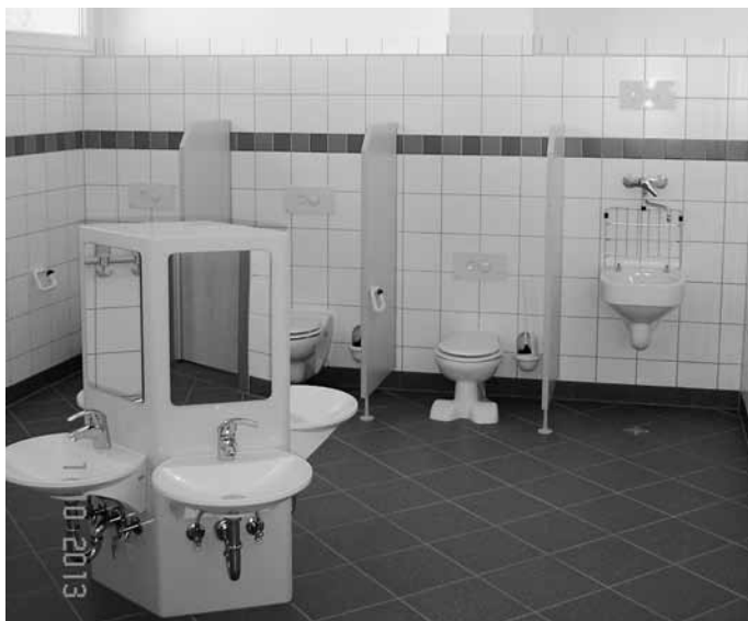
Im Bild zu sehen ist der neue Sanitärraum mit Fußbodenheizung, vier Waschbecken als Kompaktanlage, drei WCs und eine Dusche.
