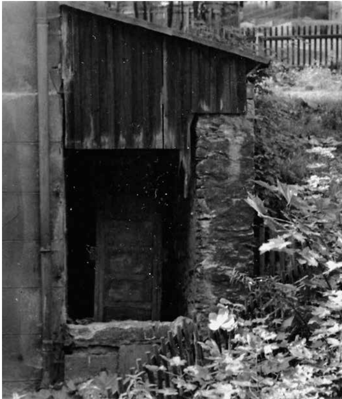
Das Wasserrad und die ehemalige Werkstatt Pfarrweg 1
