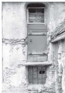
Abriss des alten Außenaufganges zur Orgelempore.
