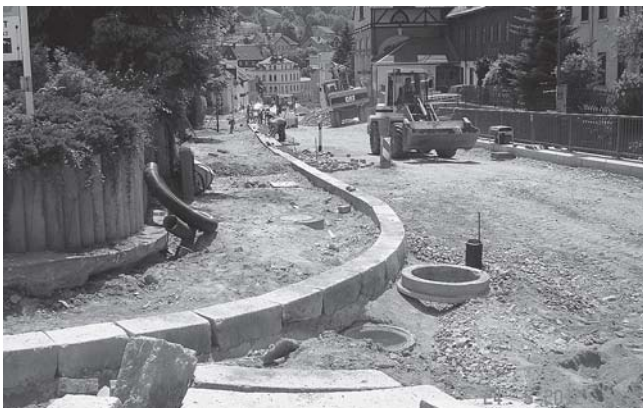
Die Arbeiten an der S 270 erstrecken sich gegenwärtig in Höhe des ehemaligen „Gasthof Krone“.
