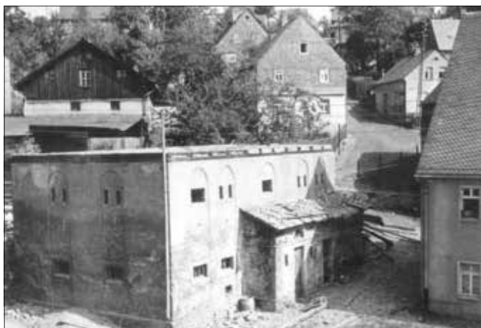
Die abgebrannte Waltherscheune vor dem Zurückbau.
