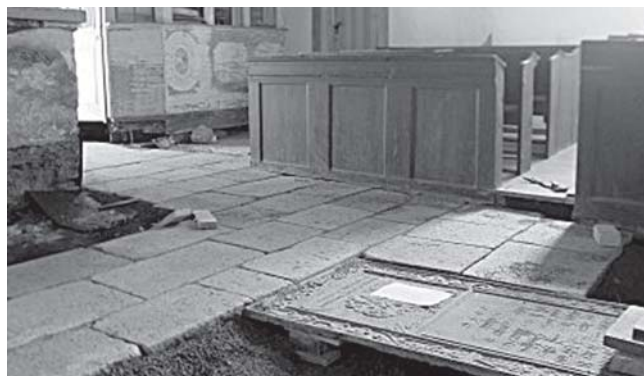
Die Verlegung der Granitplatten in den Fußboden erfolgte in den Jahren 2005 bis 2006.
