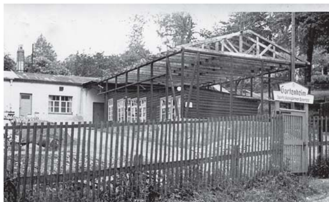
Während des Baues des neuen Kulturheimes.
