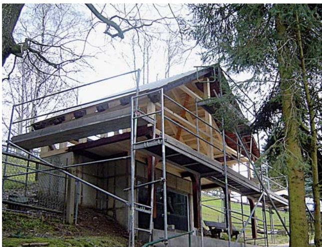
Das neue Kaltwasseraquarium in der Bauphase.
