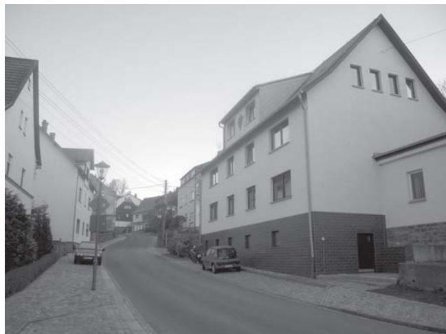
Bild 3 und 4 Wohnung und Feuerwehrgerätehaus heute.
