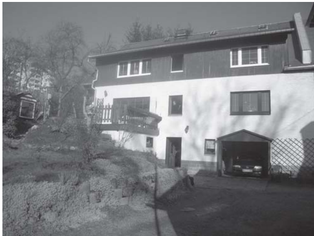
Das aus dem Umbau der Scheune hervorgegangene Wohnhaus heute.
